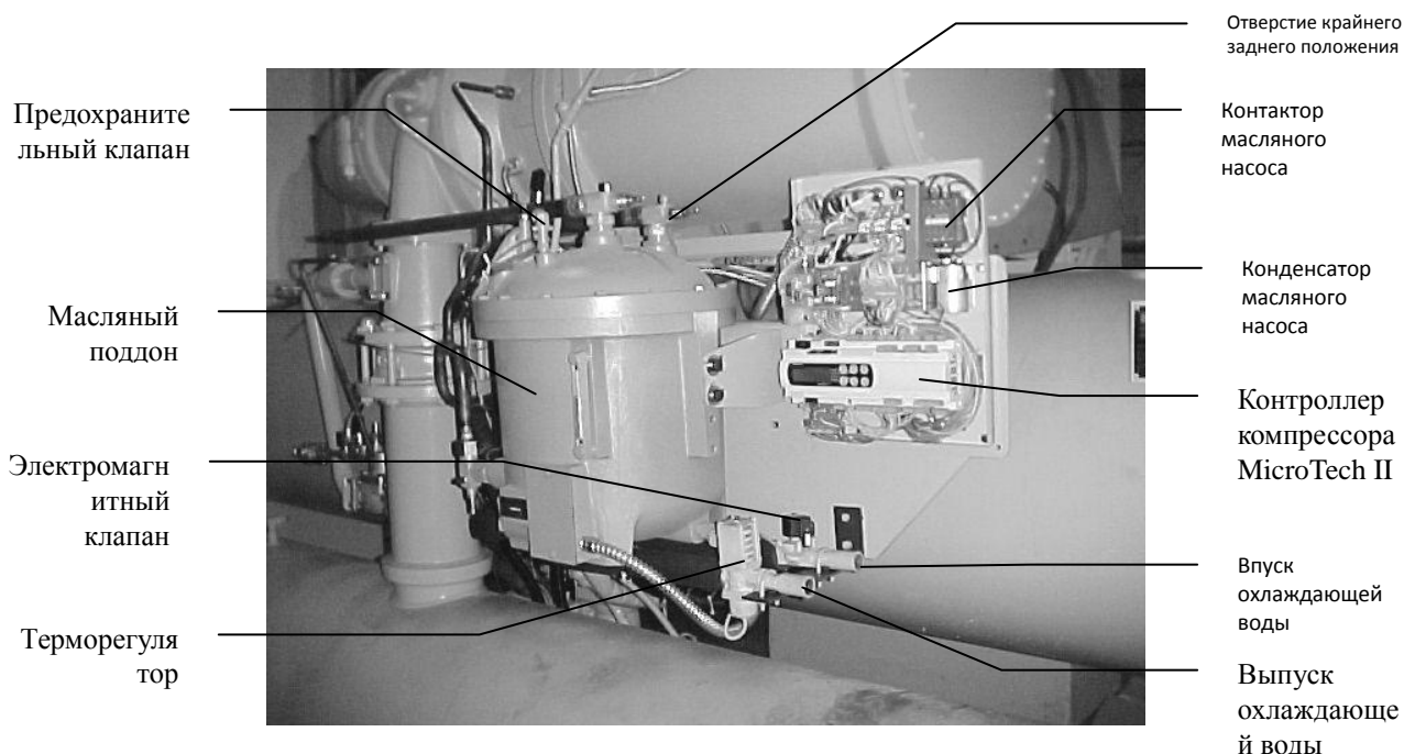
Рисунок 21. Масляный поддон и панель управления контроллером
