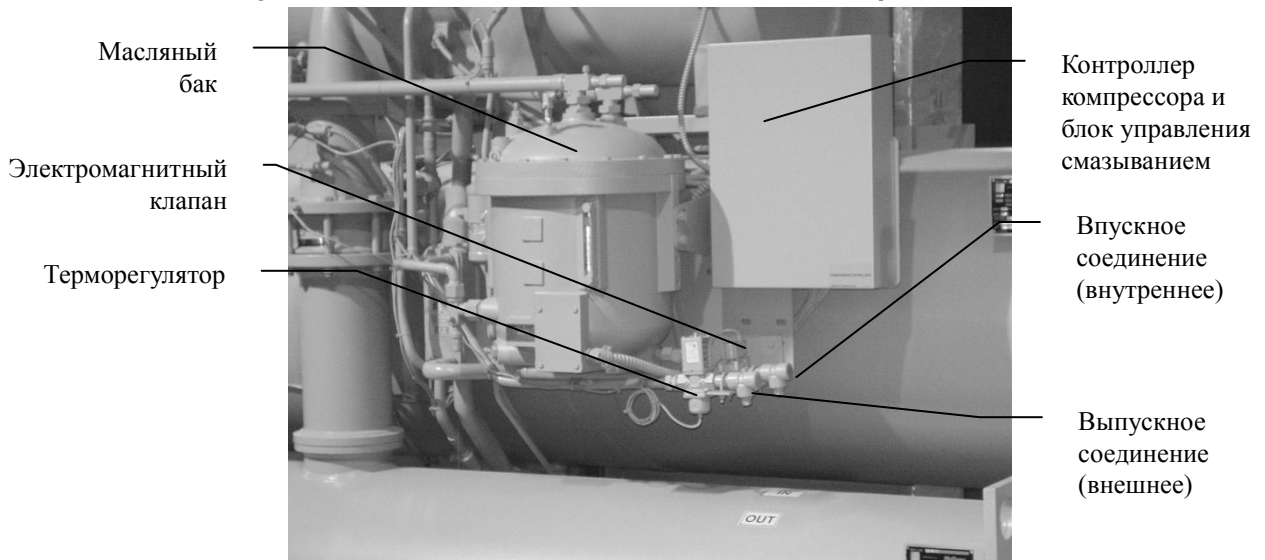
Рисунок 11. Соединения маслоохладителя агрегатов DWSC/DHSC
