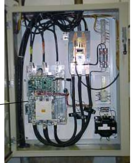
Figura 13. Conexiuni electrice la fața locului pentru afișajul opțional
