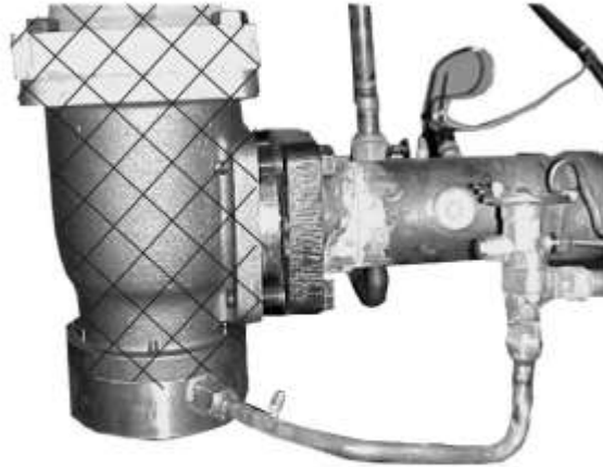
Ventil de destindere – izolați zona hașurată și până la izolația instalației de răcire
