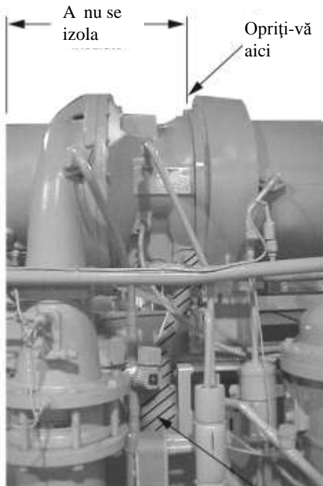
Figura 7, Cerințe de izolare, unități care funcționează doar cu răcire
