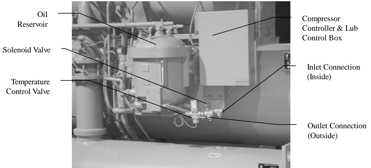
Figura 11, Connessioni circuito di raffreddamento olio per unità DWSC/DHSC
