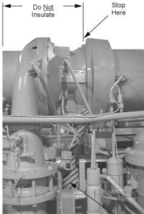
8. ábra: Szigetelési követelmények, csak hűtést végző egységeknél
