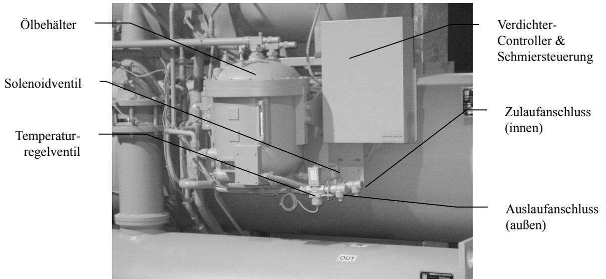
**Abbildung 12, Ölkühleranschlüsse, DWDC 100/126, 16-ft-Mäntel**
