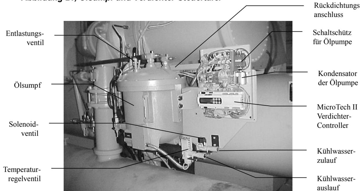
Anmerkung: 4-Wege-Solenoidventil und Klappenschließschalter befinden sich am Sauganschluss des Verdichters. Die mechanische Hochdruck-Sicherung befindet sich in der Ablassleitung.
