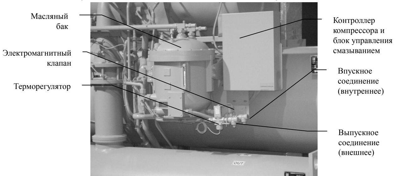
Рисунок 11. Соединения маслоохладителя агрегатов DWSC/DHSC
