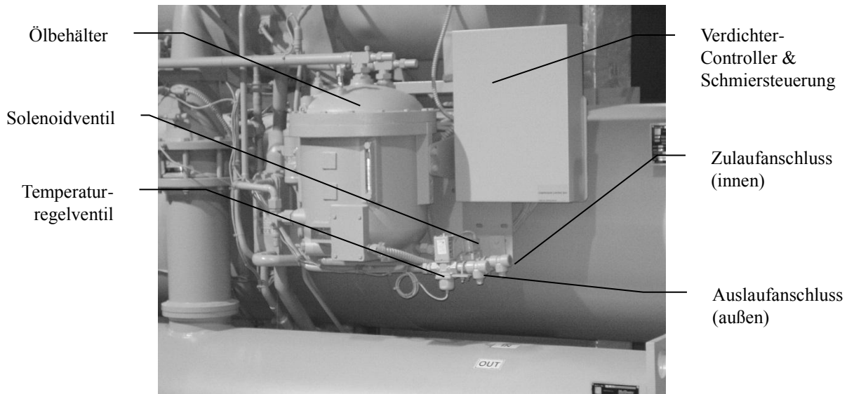
Abbildung 11, Ölkühleranschlüsse, DWSC/DHSC Einheiten
