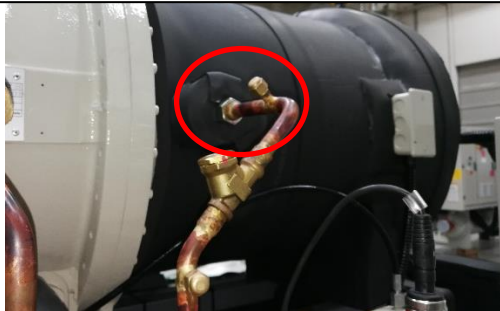
Puerto de presión del alojamiento del motor
