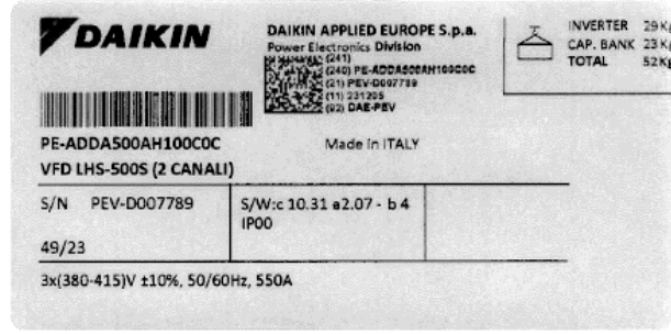
الشكل 18- ملصق تعريف محرك التردد المتغير الأيسر
