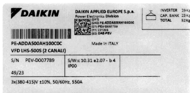
Fig. 29- Etiqueta de identificação do VFD LHS
