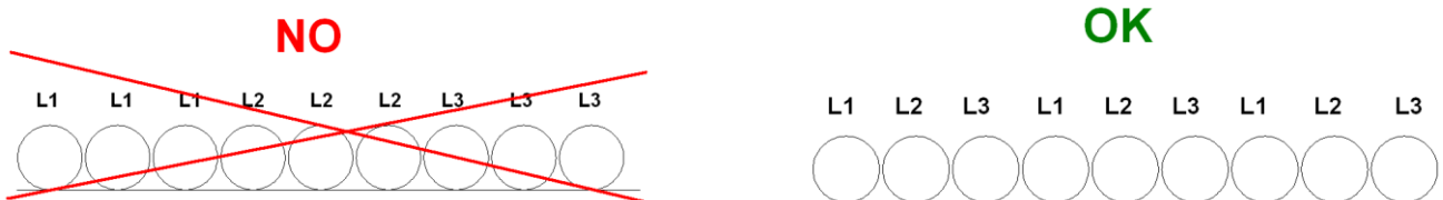
Figura 17 – Installazione dei cavi di alimentazione lunghi
