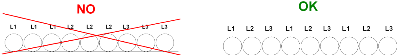
Εικόνα 17 - Εγκατάσταση μακρίων καλωδίων παροχής ρεύματος
