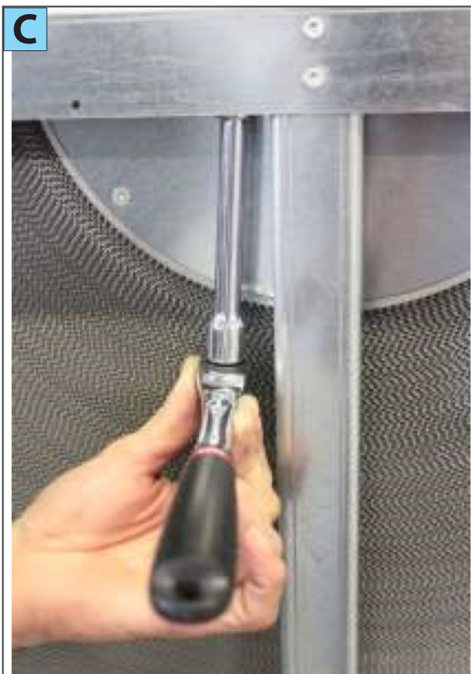
1) Afloje los dos tornillos (foto C)
